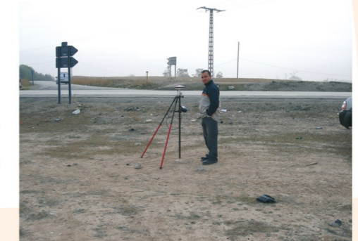
Matérialisation des sondages géotechniques Lignes à grandes vitesses (LGV) - ASMIDI 2006
