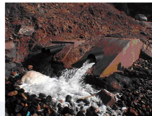
Rejet de saumure riche en oxyde de fer d'une station de désalination d'eau de mer de Ghazaouet Etude du Hot Spot de Ghazaouet (MATE)
